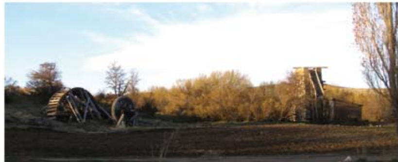
Conjunto Ruedas Aserradero - Turbina
