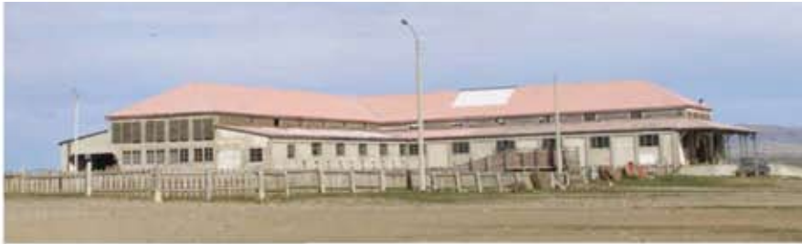
Fachada Poniente Galpón de Esquila
