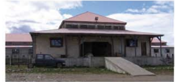
Fachada Sur - poniente Galpón de Esquila
