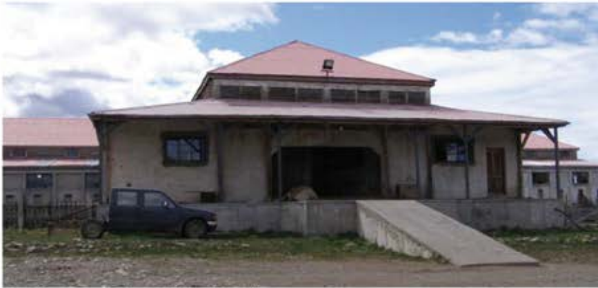
Fachada Sur - poniente Galpón de Esquila
